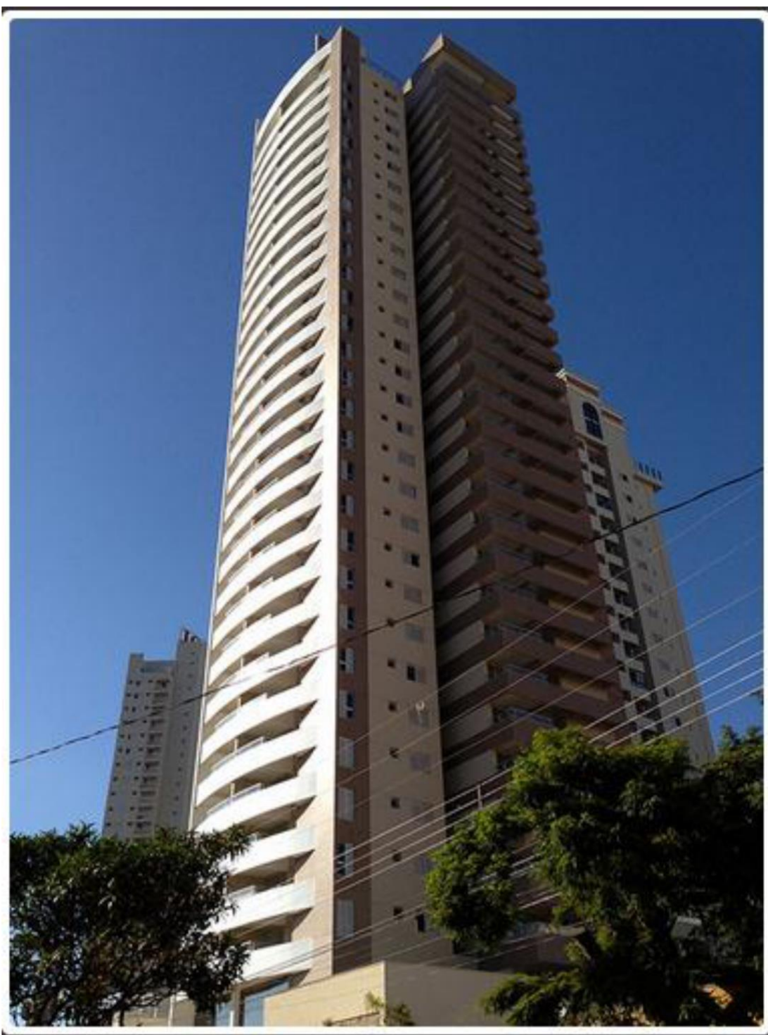
EDIFÍCIO VISAGE ARENA - GOIÂNIA - GO
